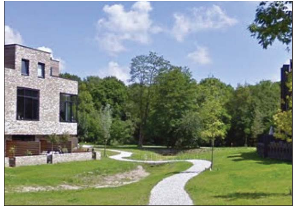
Directe overgang, buitenruimte als bouwkundig onderdeel architectuur en oriëntatie op het landschap (De Hoef Zuid)
