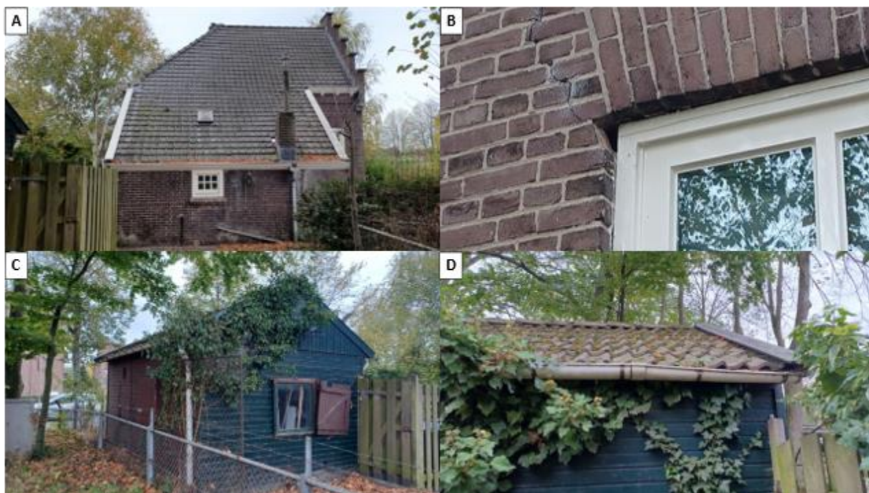
Figuur 4.2 Overzicht gebouwen met mogelijke verblijfplaatsen voor vleermuizen. Grotere foto's zijn toegevoegd in bijlage 2.
