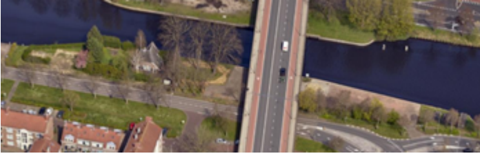
Figuur 2.4. Sluiswachterskade vanaf het zuiden kijkend
