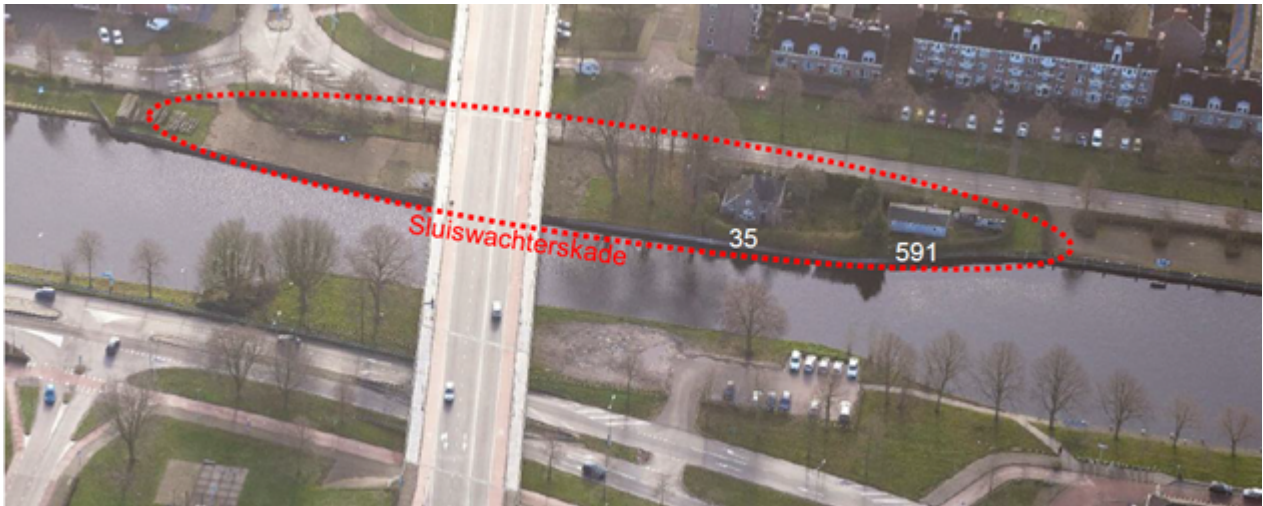
Figuur 2.8: Zicht vanaf noorden op het plangebied en het omliggende terrein, met het Sluiswachtershuis op nummer 35 en het inmiddels gesloopte houten huisje Van Veldekekade 591.
