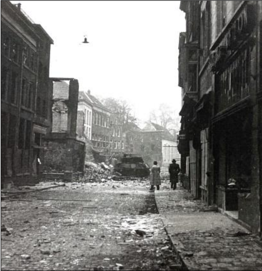
Afbeelding 63: De uitgeschakelde Britse tank in de Visstraat. De schade aan de omliggende gebouwen is groot. Bron: SADB 's-Hertogenbosch toeg.nr. 0824 inv.nr. 67.
