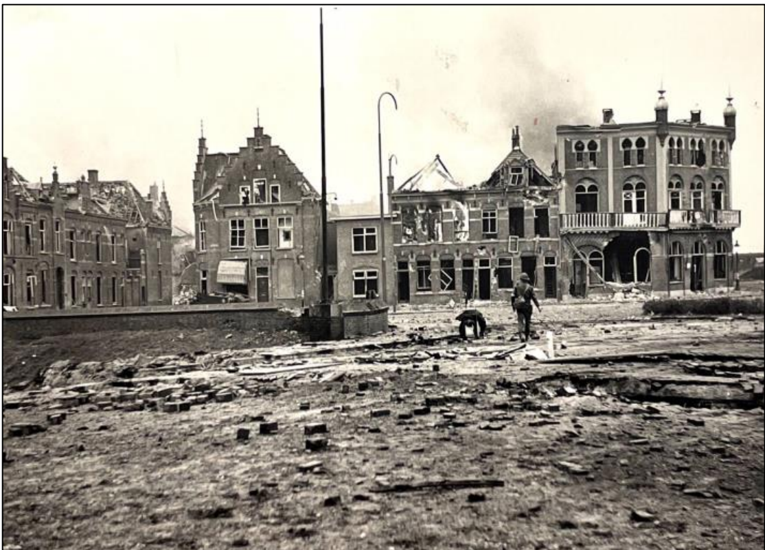
Afbeelding 69: De Willemsbrug met Britse eenheden (waarschijnlijk de East Lancashire Regiment). Op de voorgrond, rechts, is het gat in de brug te zien. Meerdere gebouwen stonden in brand. SADB 's-Hertogenbosch toeg.nr. 0824 inv.nr. 1240.
