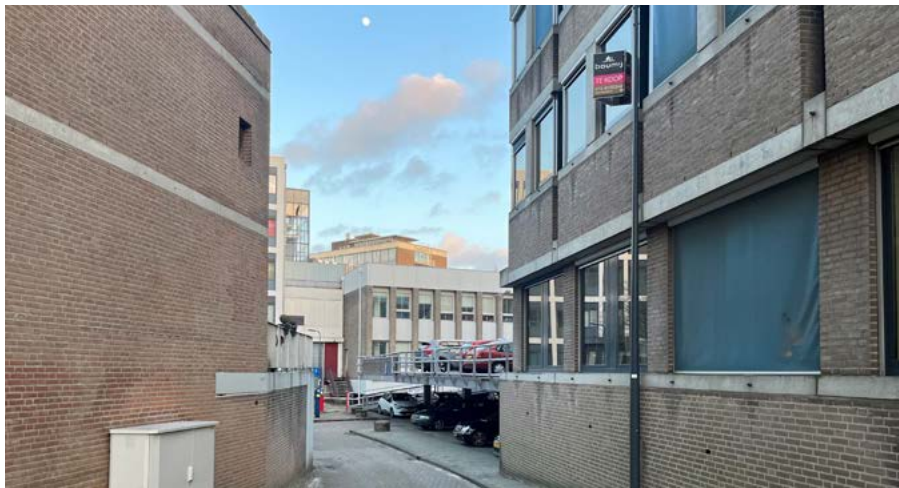
Afbeelding 3.9b Foto bestaande situatie
