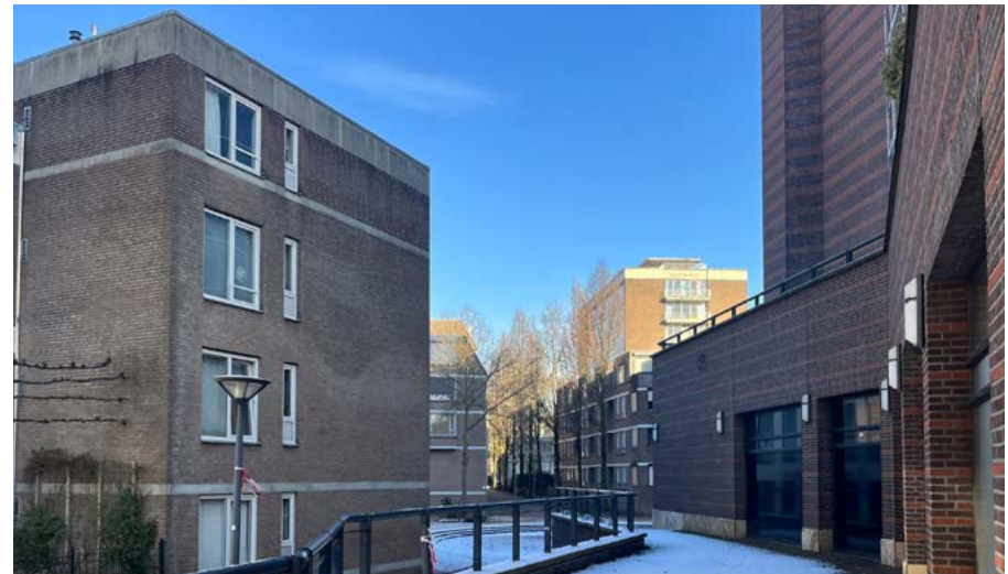
Afbeelding 3.10b Foto bestaande situatie
