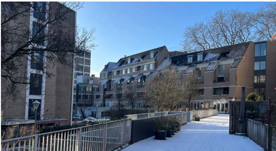
Afbeelding 3.13b Foto bestaande situatie
