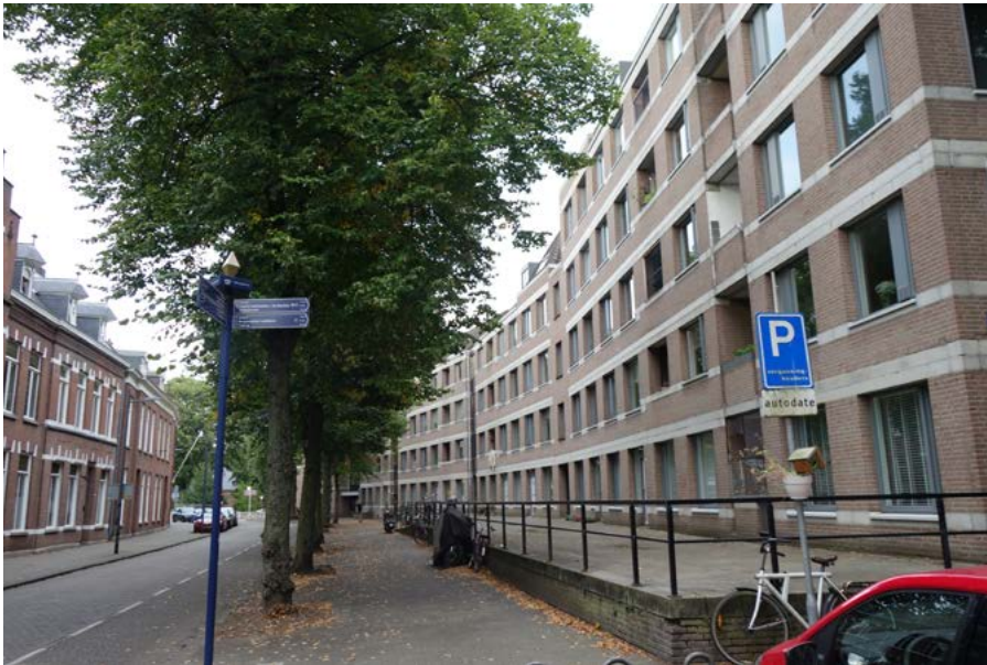
Afbeelding 4.4 De woningen aan de buitenrand worden gerenoveerd, foto Jan Heinsstraat
