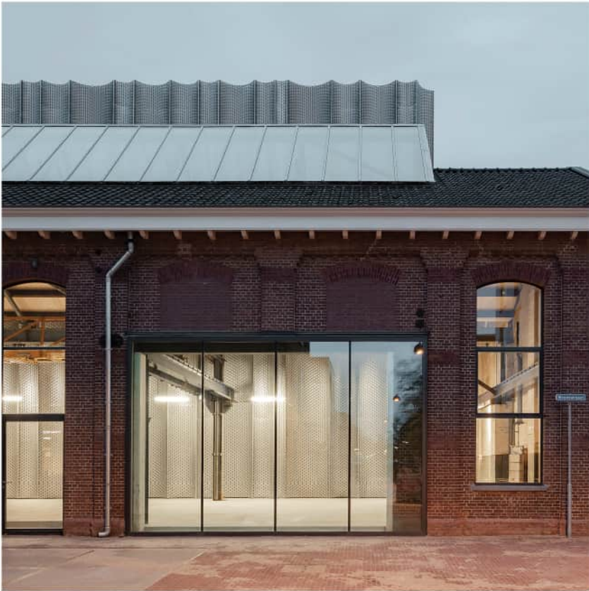
Bovenwerkplaats, Utrecht Studionedots | © Sebastian van Damme
