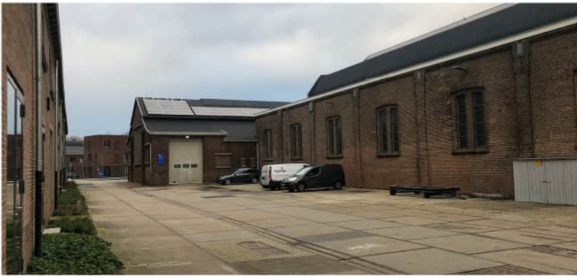
Industriële openbare ruimte rondom GEA-fabriekshallen
