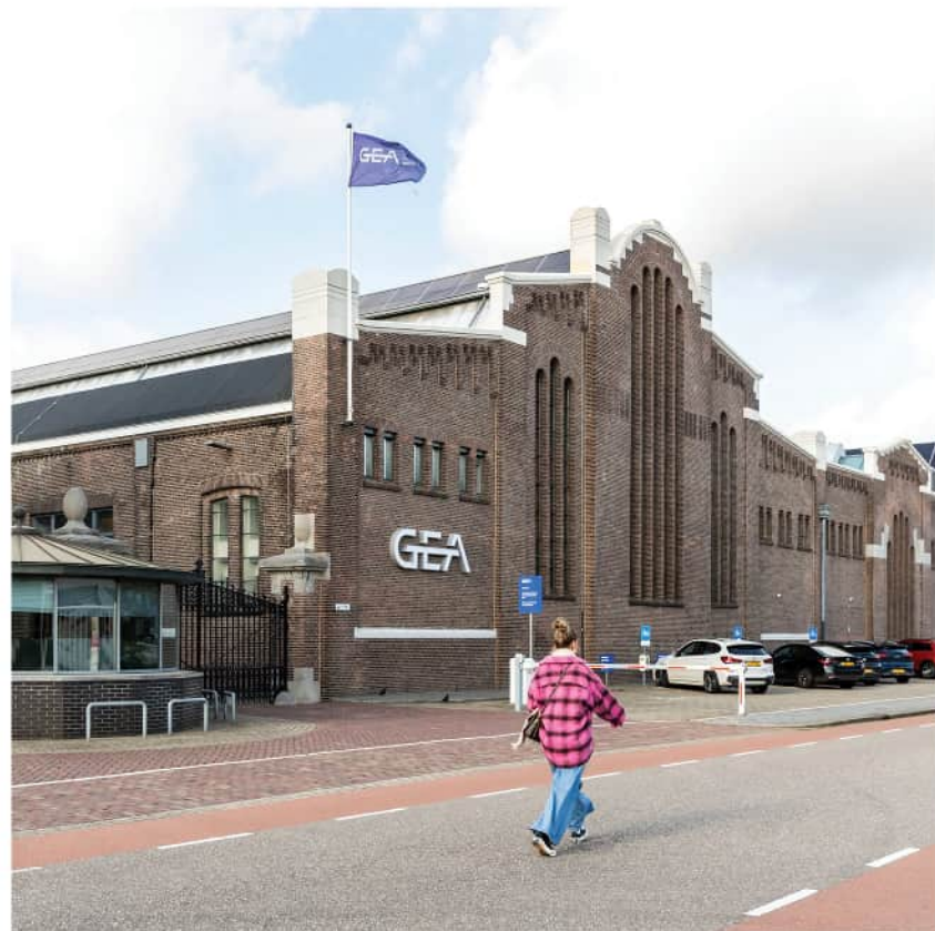
Parallelweg zicht op GEA Fabriekshallen
