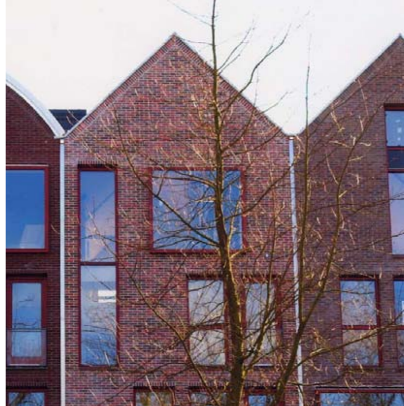
Enkhuizen, wonen, Rijnboutt Van der Vossen Rijnboutt
