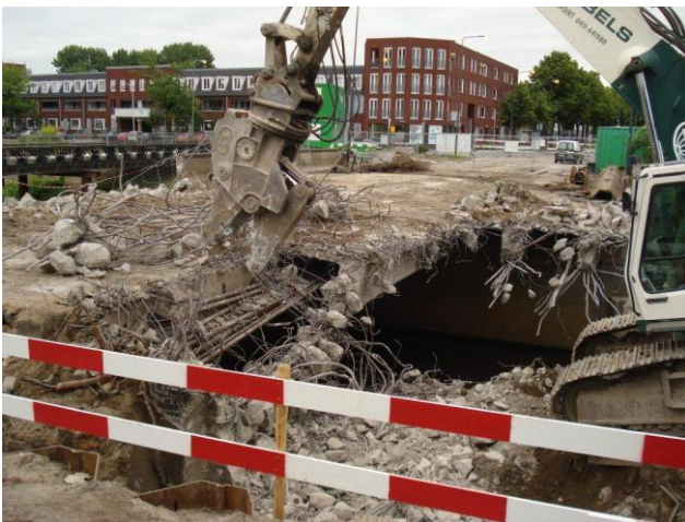
Figuur 8 Sloop van de Bartenbrug (juni 2012)
