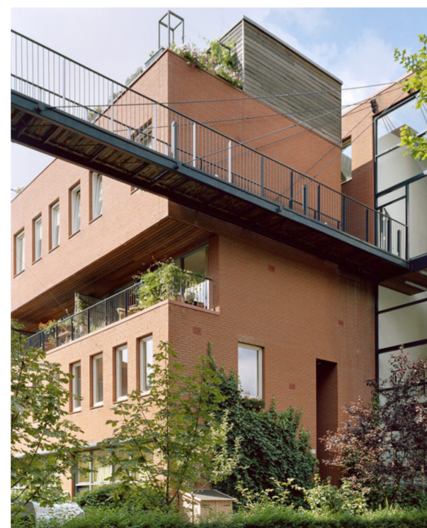
De struinroute loop door een open blok. De galerijen lopen op hoogte door en worden extra zichtbaar gemaakt.
