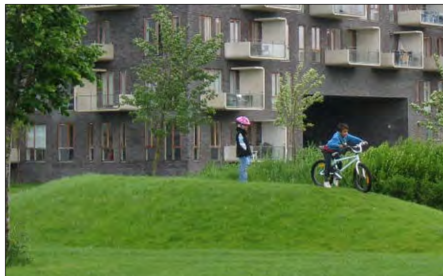
Hoogteverschillen tussen de woongebouwen
